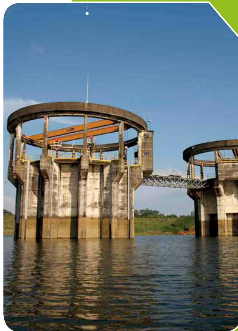
Torres de captación. Central Hidroeléctrica San Carlos
