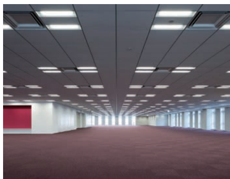
居室内の照明はLED照明を採用しています。
