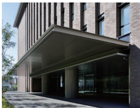
窓は二重窓を採用し、空調効率を上げて省エネルギー化しているほか、耐久性の高いチタン屋根を採用しています。
