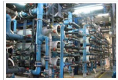
逆浸透膜による淡水化工程 (SWRO)
