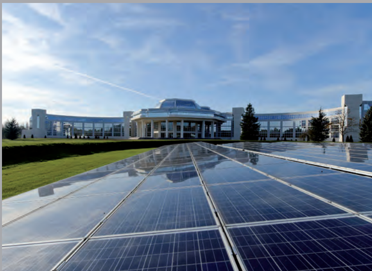
Challenger, siège social de Bouygues Construction, en cours de rénovation environnementale
