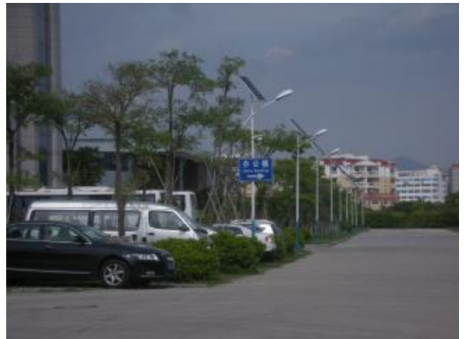
厂内太阳能路灯
