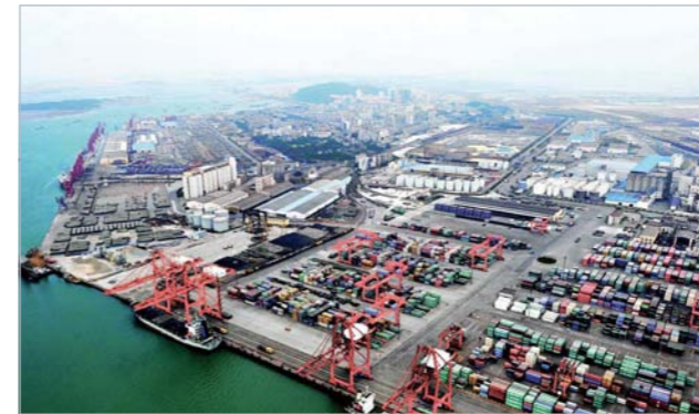
北部湾港口建设 Port Construction in Beibu Bay
