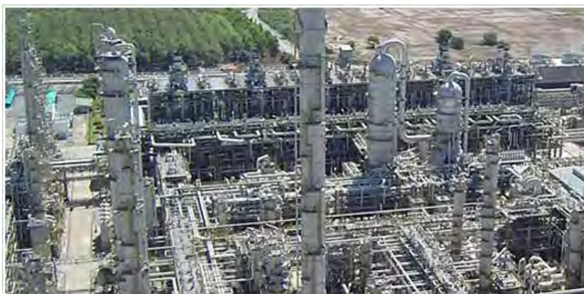
ROC社プラント
