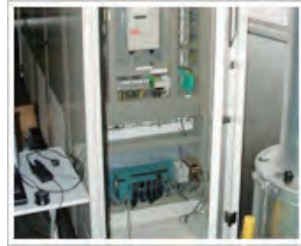
温室のキャビネットに組み込まれた STARDOM調節計
