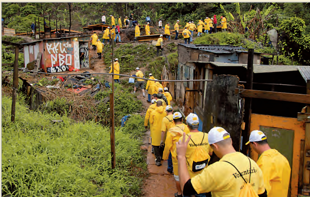
Construcción de viviendas de emergencia a cargo de voluntarios Prosegur, Brasil Septiembre de 2010.
