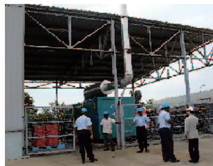
発電機の排ガス計測(コマツインドにて)
